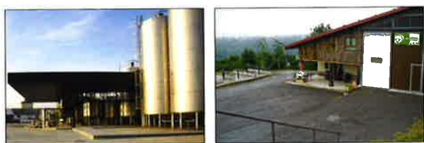
Fig. 3. Diferentes tipologías de queserías según el tamaño de la instalación (izquierda: quesería grande, derecha quesería mediana).
